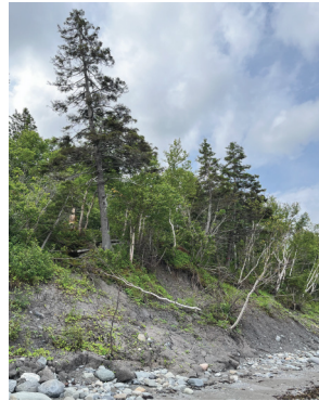
Berge de Métis-sur-Mer, 2023 : des arbres tombent suite à un glissement de terrain...
